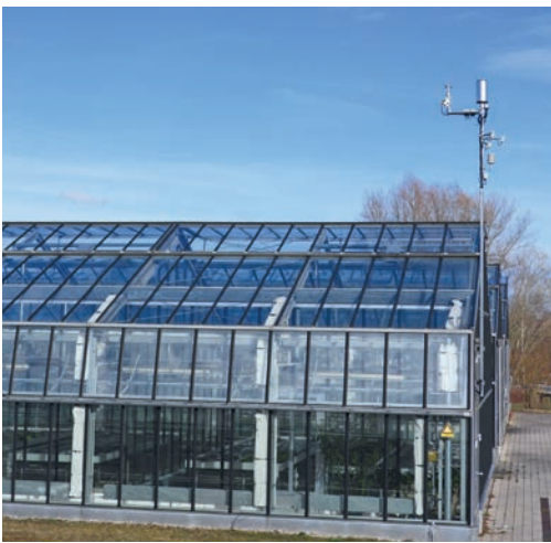
Sensoren im und am Gewächshaus messen Lichteinfall, Luftfeuchtigkeit und Temperatur, um sie den Klimabedingungen automatisch anzupassen. Das schont Ressourcen und macht die Produktion nachhaltiger.
